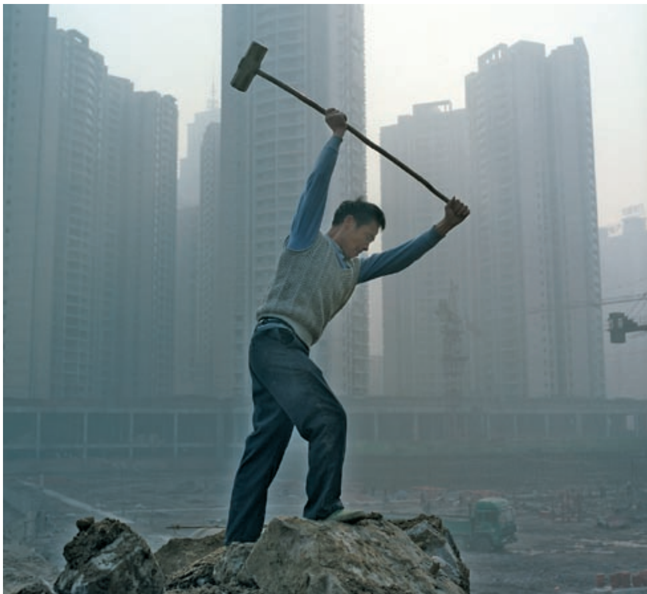
Herr Xian, 50, Wanderarbeiter aus der Provinz Sichuan, arbeitet auf einer der unzähligen Baustellen in Chongqing. Chongqing, Chongqing Stadt. März 2008. Bild: Andreas Seibert
